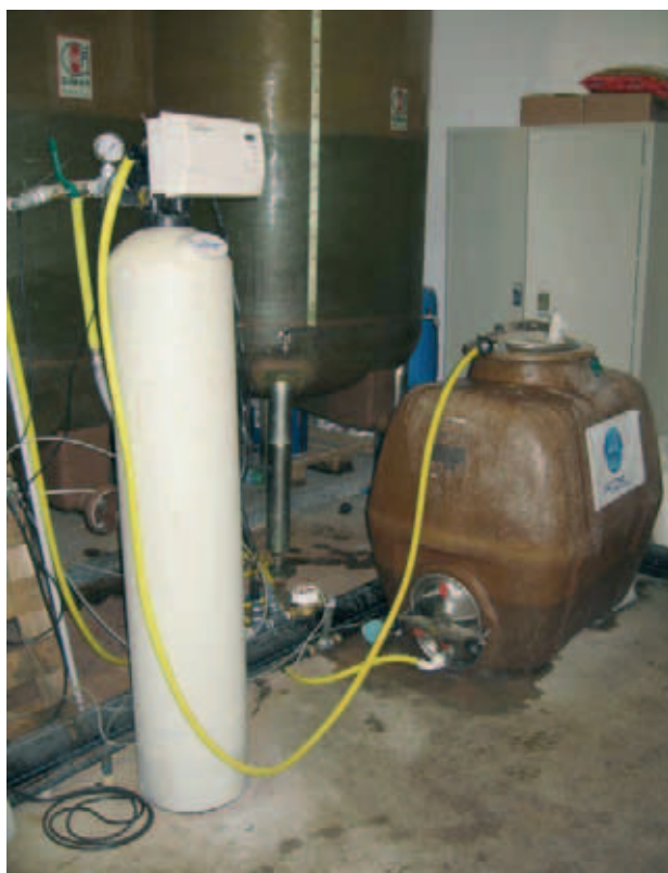
Foto 2 – Filtro Culligan Cullbrook 10, impiegati sia con mezzi filtranti adsorbenti che con mezzi filtranti inerti (coagulazione/adsorbimento)
