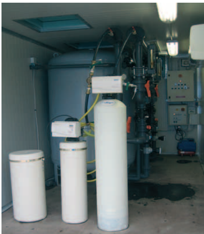
Foto 8 – Impianto pilota con nuova resina
