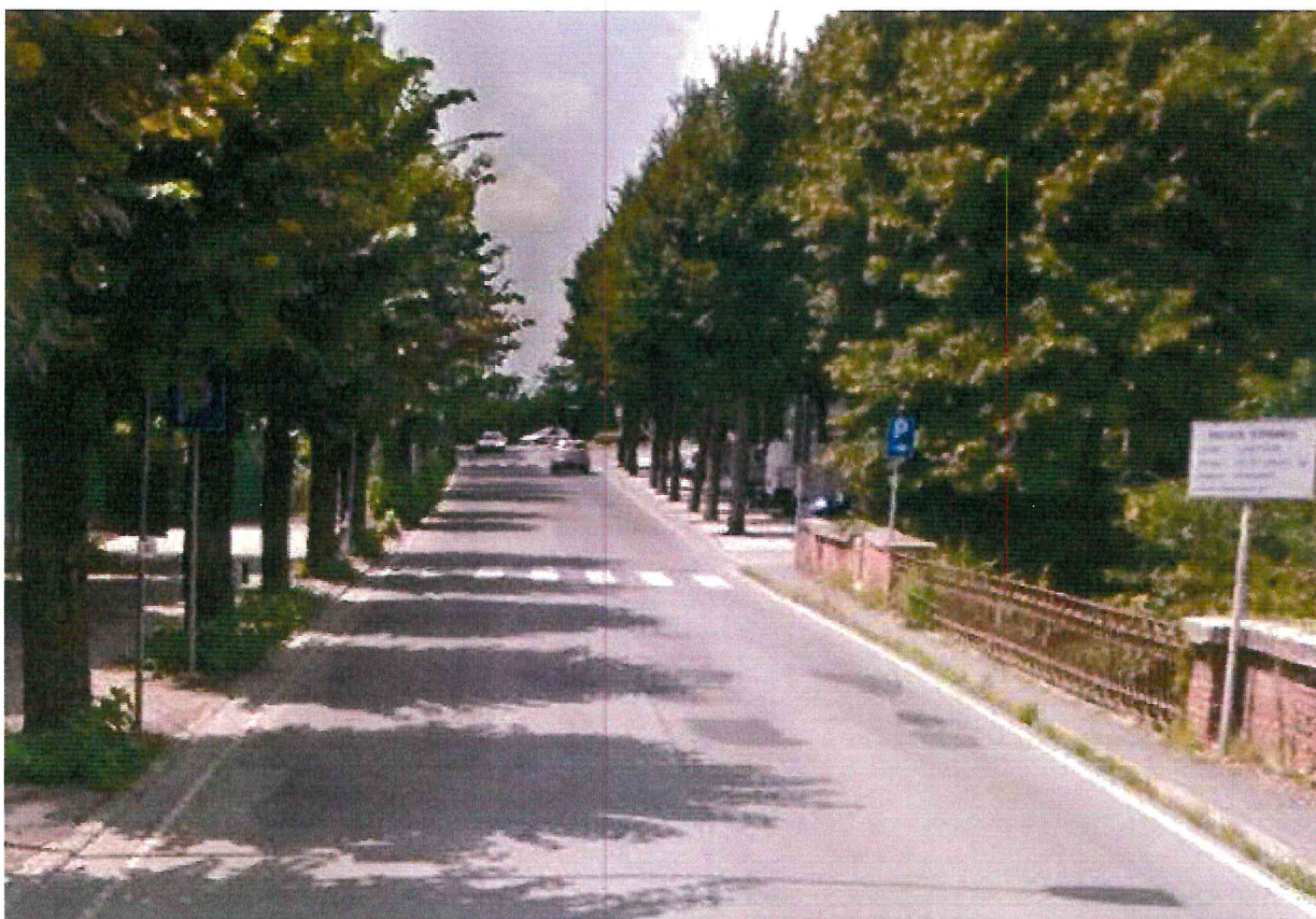
Figura 2: Viale Einaudi su ponte Rio Ravanasco – Vista direzione Acqui Terme – Stato attuale
