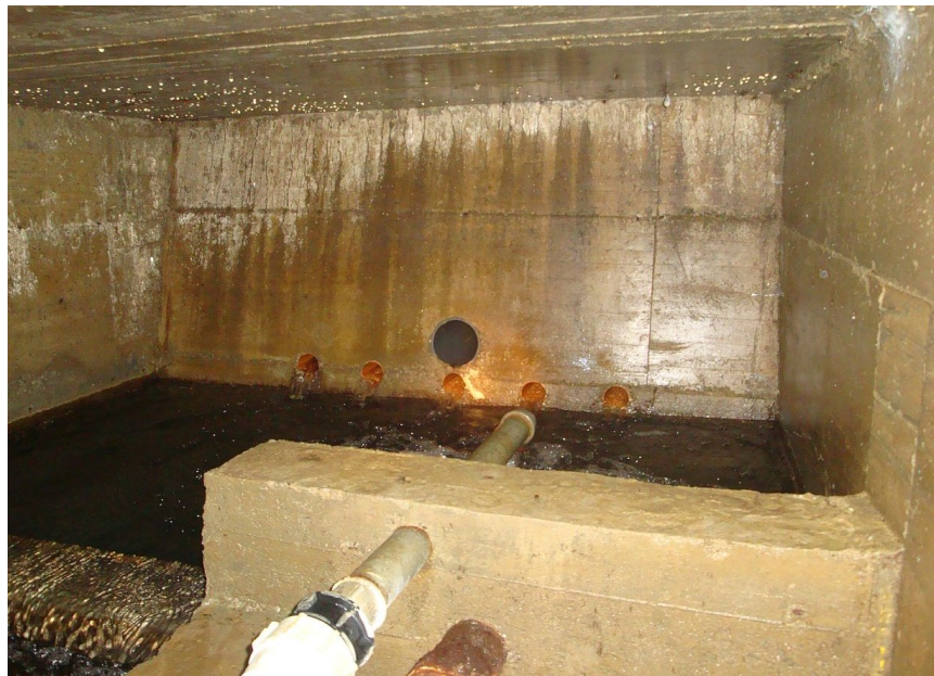
Foto 1 – La vaschetta di raccolta delle captazioni (cabina di partenza condotta); in essa convergono:
