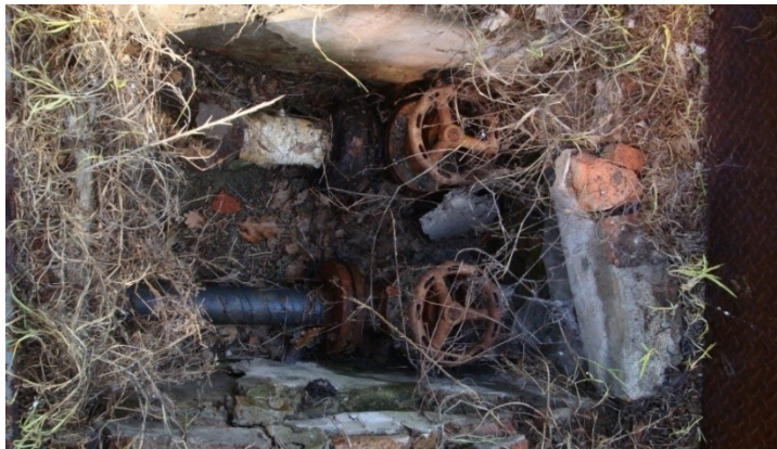
Foto 6 – Pozzetto di alimentazione di Montaldeo a valle della vasca secondaria di loc. Madonna di Pompei; anche in questo caso si noti il degrado degli organi di controllo.
