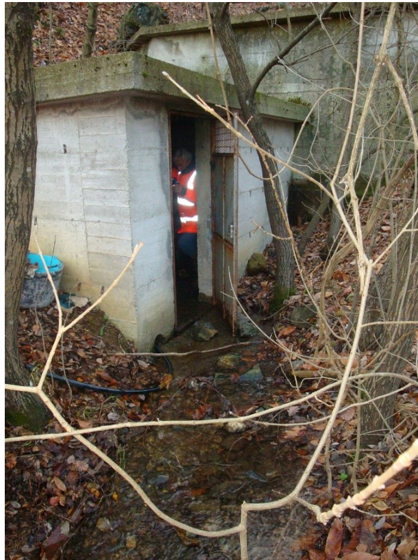
Foto 3 – La cabina di partenza della condotta per Bosio, con il ruscello d'acqua fuoriuscente dalla porta a causa dell'eccessiva portata delle sorgenti; si può stimare una portata persa non inferiore a 2 \div 4 l/s.
