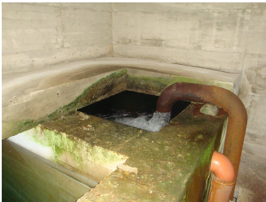
Foto 4 – L'arrivo nella vasca di Bosio della condotta proveniente dalle sorgenti in loc. Friscellana. La portata misurata ammonta a 8,0 l/s (dicembre 2016).
