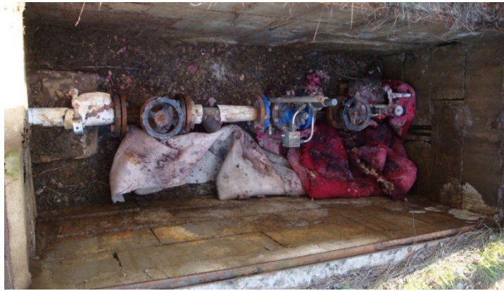
Foto 5 – Pozzetto di alimentazione della vasca di Mornese; si noti il degrado degli organi di controllo.
